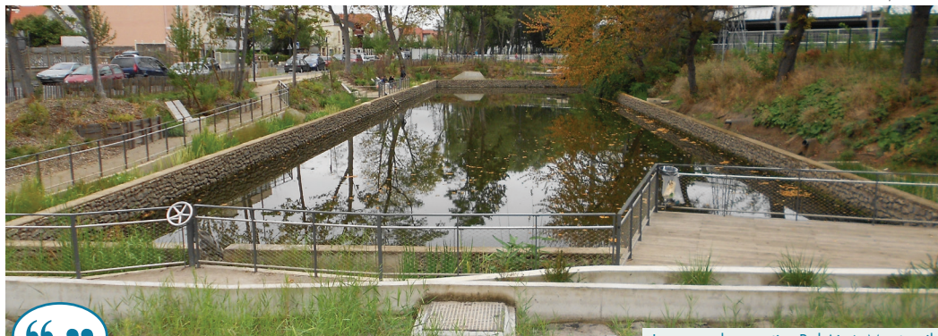
La mare du quartier Bel-Air à Montreuil
